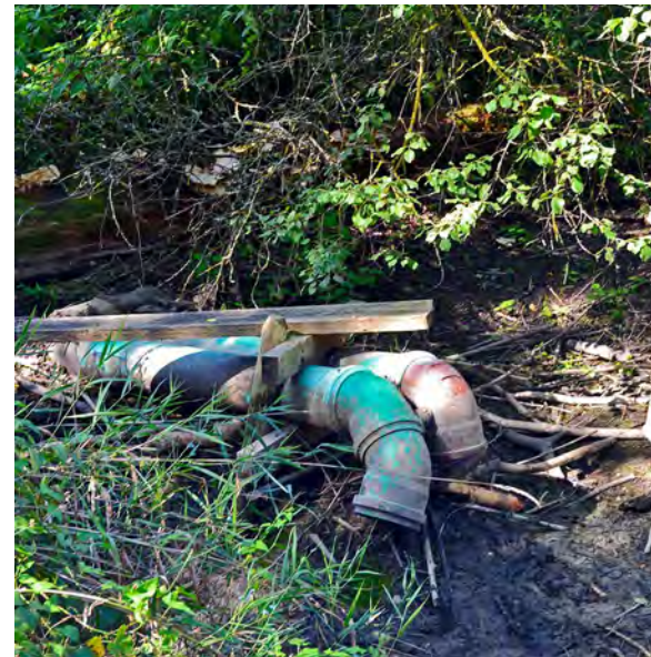
Unkonventionelle Massnahme: Plastikrohre lassen Wasser neben dem Biberbau abfließen.
