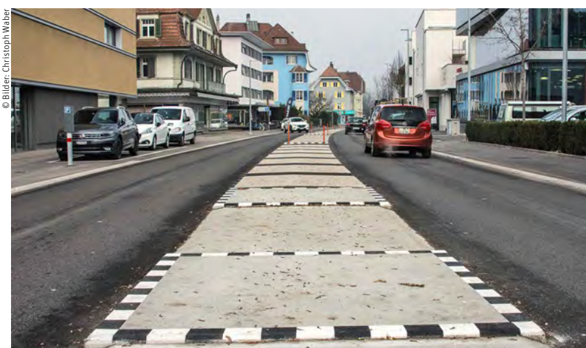
Auf der Bielstrasse hat sich mit der Umgestaltung einiges zum Besseren gewendet.
